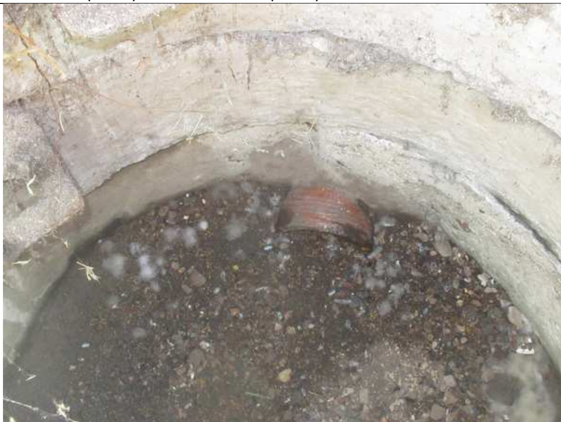
Obr. č. 5 - pohled na pravděpodobně přívodní kameninovou rouru od JV
